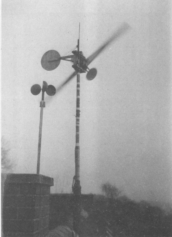
Idealer Standort - Windrad auf dem Dach (gebaut 1981, das erste Direktantrieb-Windrad). Davor ein Eigenbau-Windmesser.
