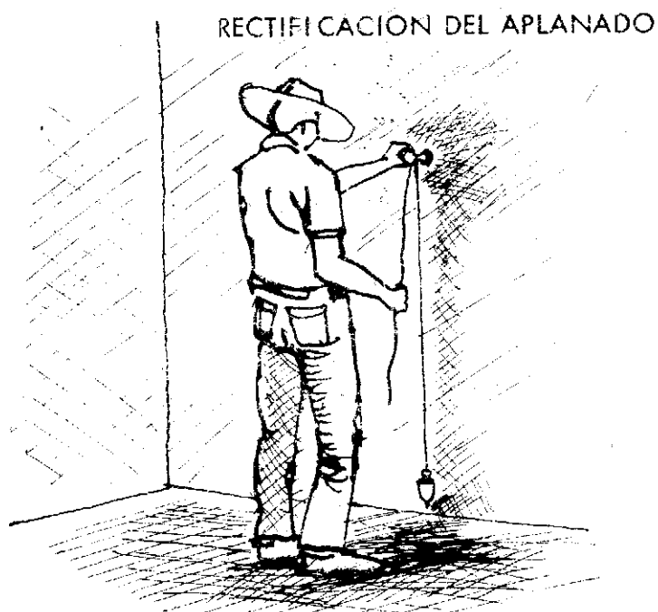
Rectificación del aplanado a plomo.
