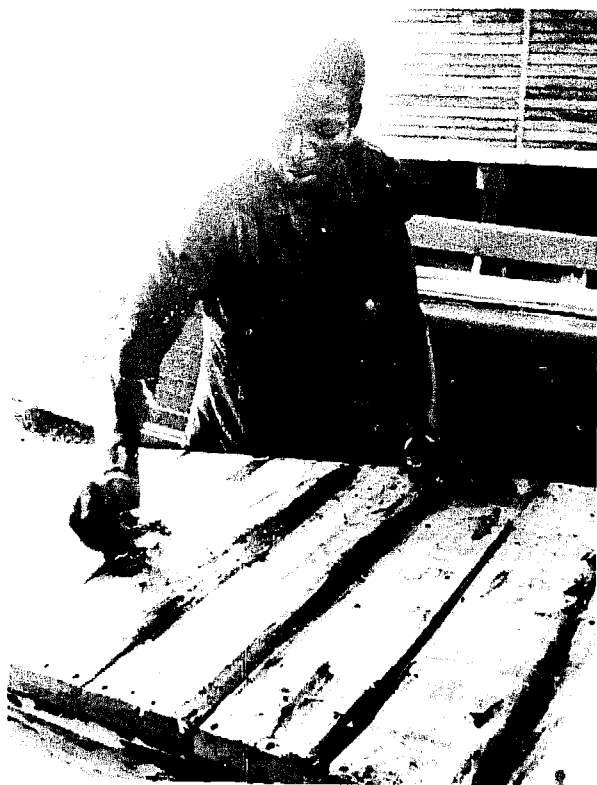
Fig.170 Nettoyer le surplus de produit d'étanchéité aux joints Fig.170 Clean off surplus putty
