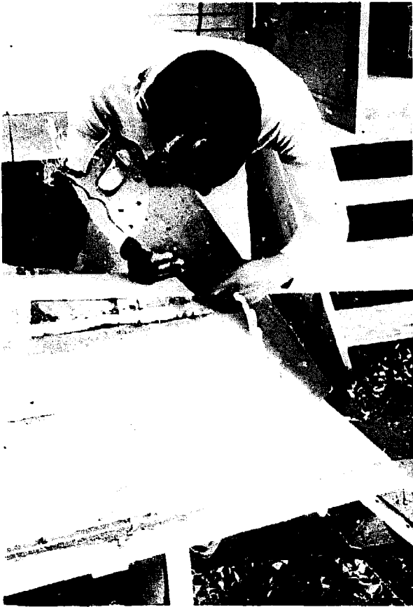
Fig.175 Après avoir fixé la quille sur le fond avec les clous de 7 cm espacés de 30 cm, tracer les bouts et couper Fig.175 After nailing the keel on the bottom and inner keel with 2 3/4" nails spaced 12", trace ends and cut off
