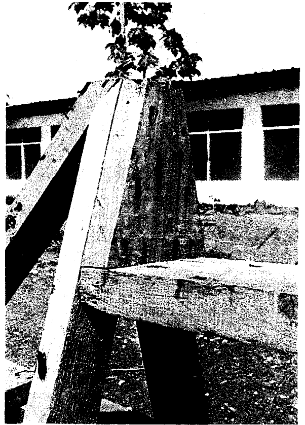
Fig.57 Fixer la planche longitudinale H contre le dessous des taquets de montants obliques et contre le dessous des planches de montant
